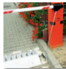
Mechaniczne połączenie kolczatki ze szlabanem.
